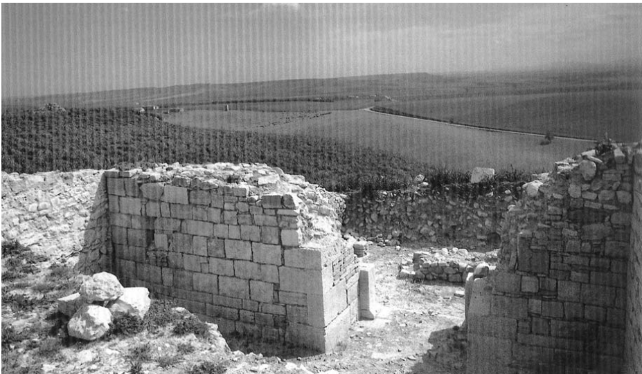
FIORENTINO La domus federiciana Veduta a Sud dei resti dell’ingresso principale
